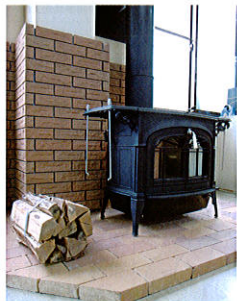
【薪ストーブ設置】
